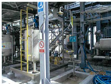
ภาพที่ 2.2-27 อุปกรณ์ชำระล้างฉุกเฉิน
