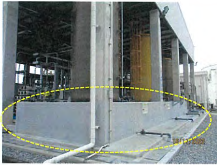
ภาพที่ 2.2-33 คันคอนกรีตรอบถังเก็บสารเคมี
